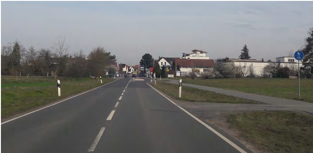
Abbildung 2.1: Bergstraße, Blickrichtung nach Norden
