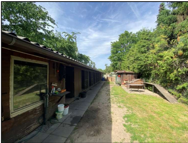
Abbildung 10: Zwinger und Aufenthaltshütten
