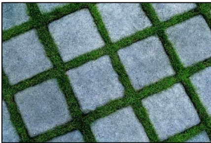
Abbildung 2 Beispiel wasserdurchlässige Befestigung, Rasenfugenpflaster
