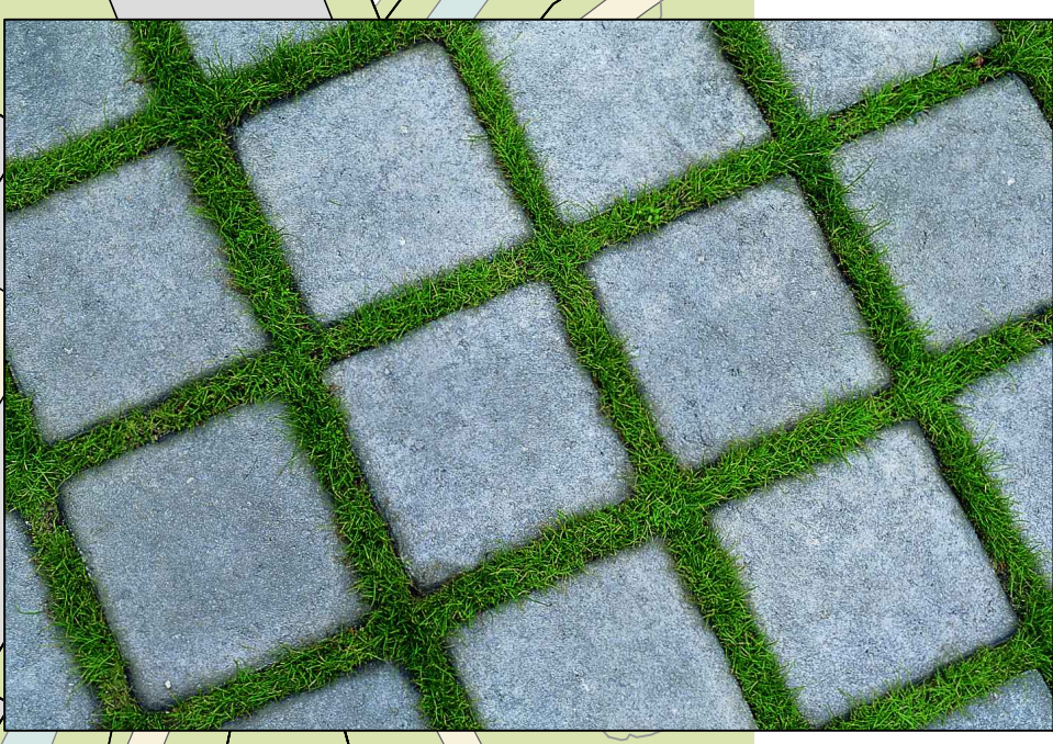
Beispiel wasserdurchlässige Befestigung
