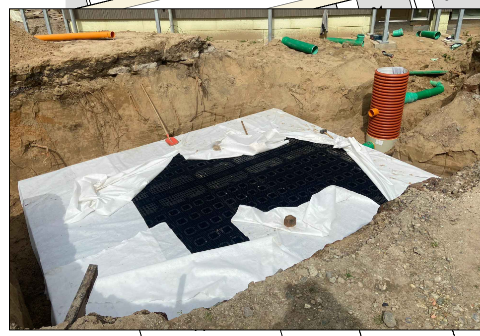
Beispiel Versickerungsrigole (Kunststoffrigole)
