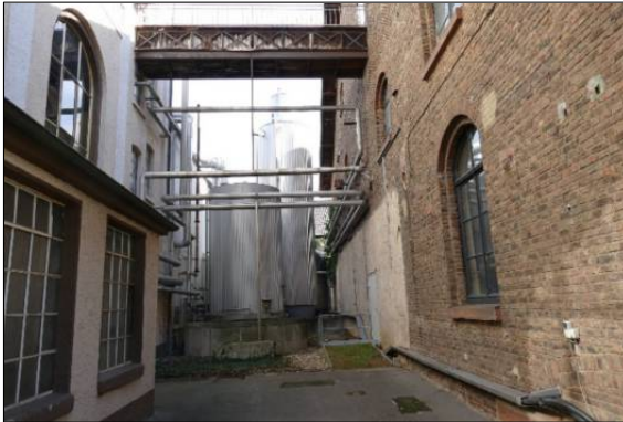
Abbildung 7: Historische Gebäude (rechts Maschinenhaus, links Sudhaus) mit modernen Tankanlagen
