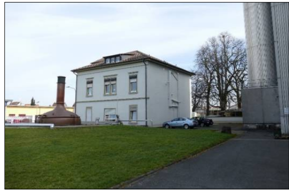
Abbildung 10: Wohngebäude an der Eberstädter Straße, links im Bild ein alter Kupferkessel, rechts im Bild das moderne Tanklager
