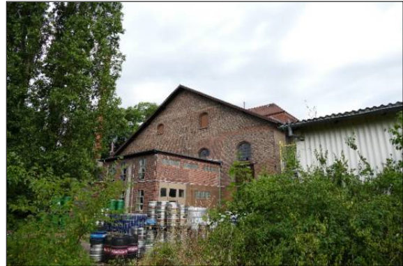
Abbildung 8: Historisches Maschinenhaus mit vorgelagertem Kesselhaus
