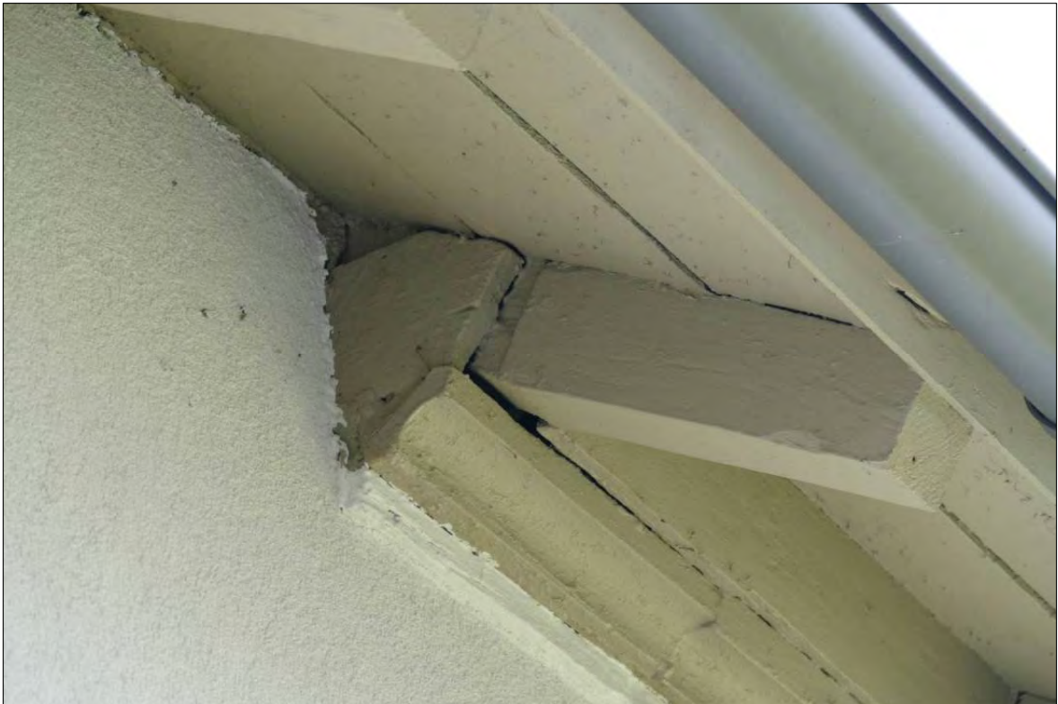
Abbildung 29: Nischenbildung hinter einer Dachkonstruktion als potentielles Fledermaus-Tagesquartier
