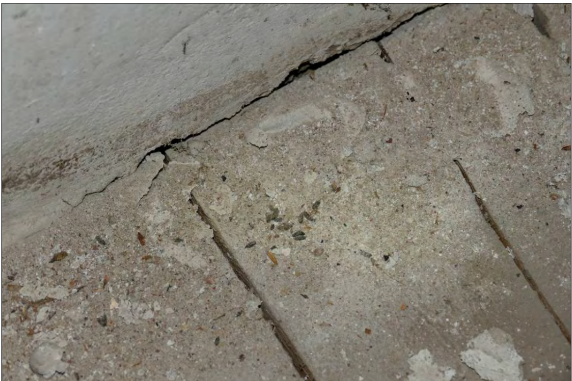
Abbildung 28: Fledermauskot auf einem Dachboden
