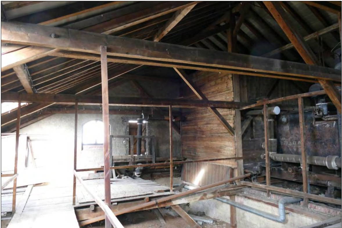
Abbildung 27: Dachboden mit Quartierpotential für Fledermäuse
