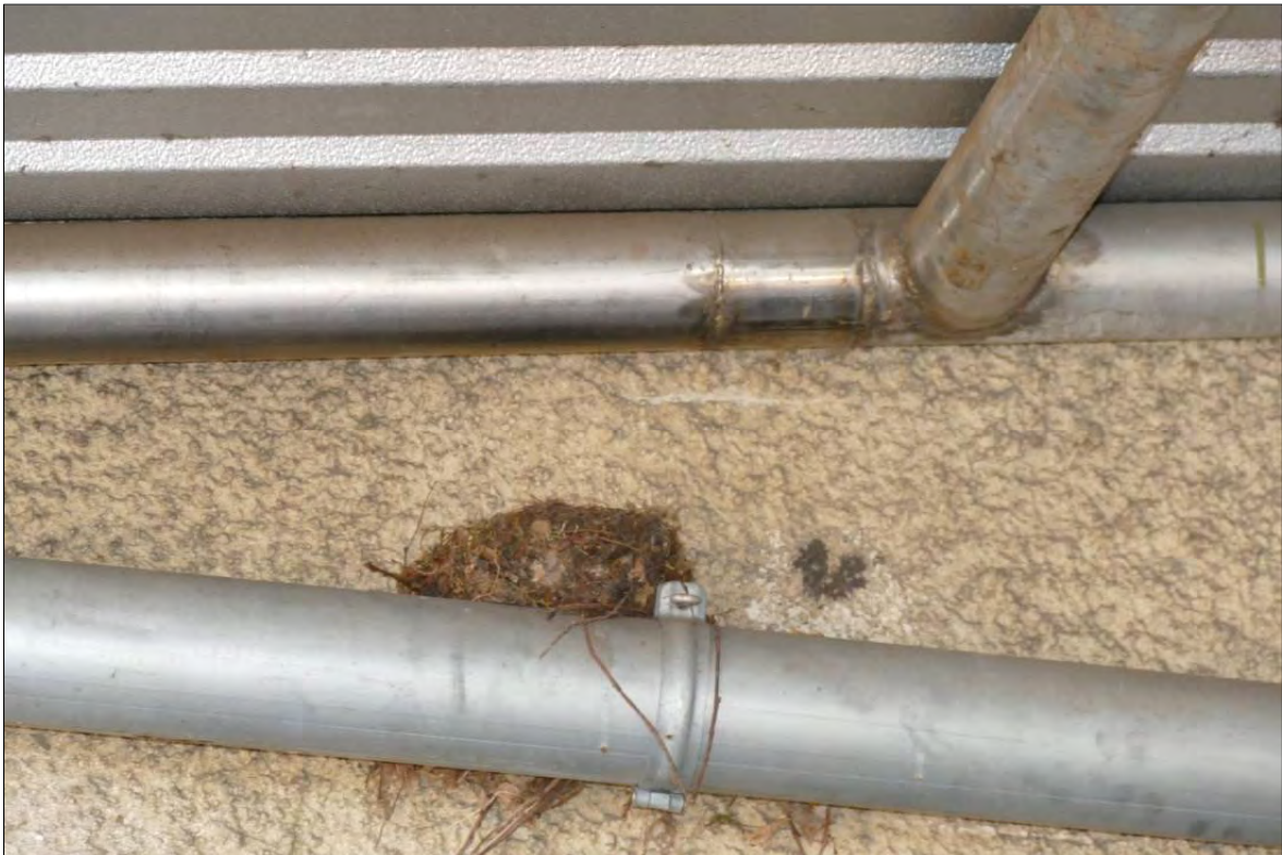
Abbildung 31: Vorjähriges Vogelneest an einem Gebäude
