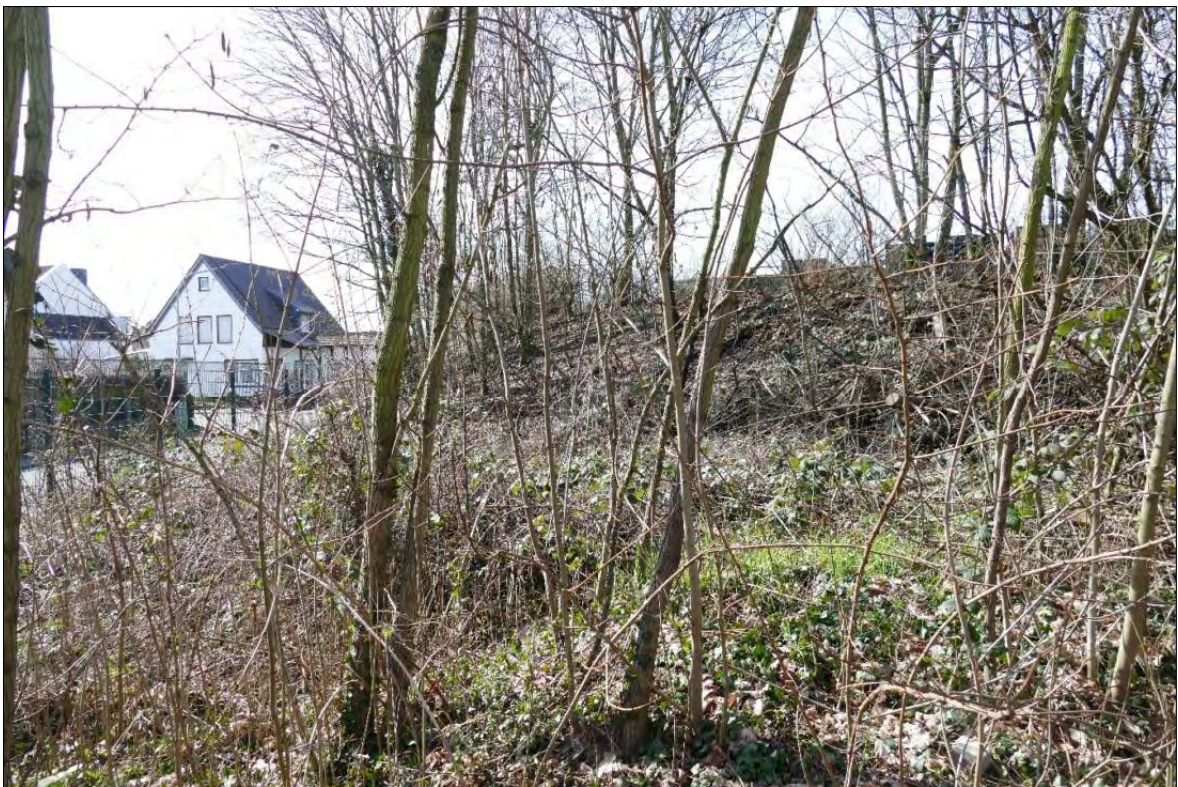
Abbildung 24: Gehölzbestandener Lärmschutzwall im Südosten
