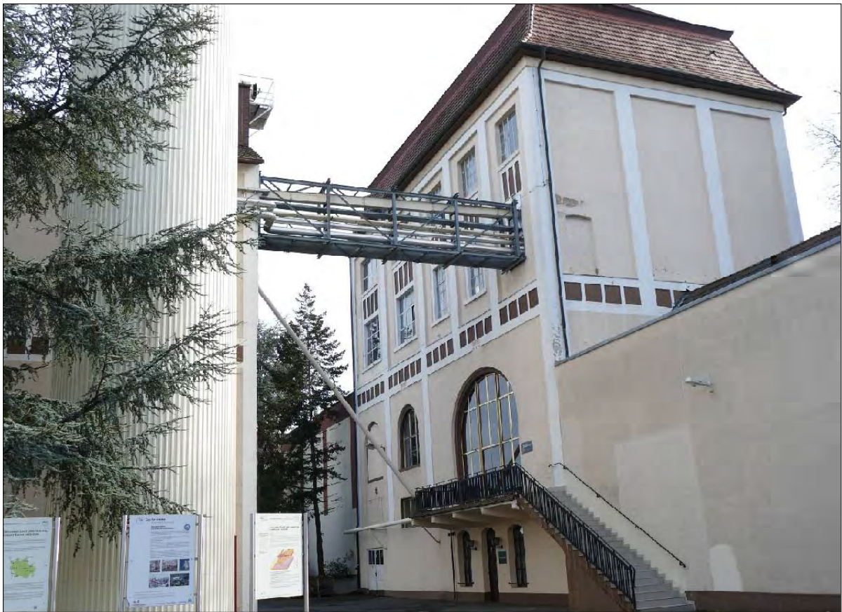
Abbildung 4: Altes Sudhaus mit Tanks
