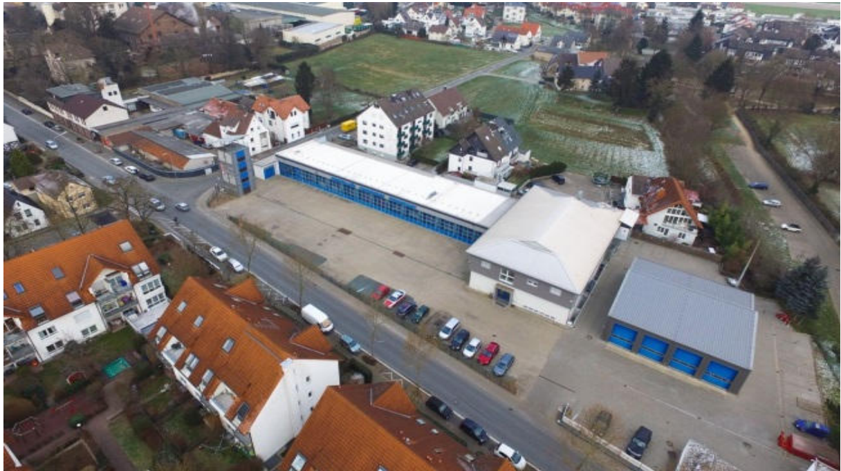
Abbildung 3 Feuerwehrhaus Pfungstadt / Mühlenstraße 24 1
